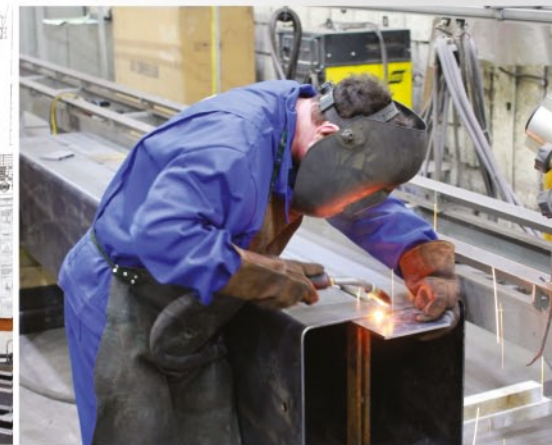
Sudură manuală prin puncte. Manual tack welding.
